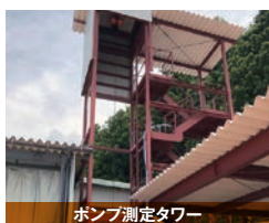
ポンプ測定タワー
