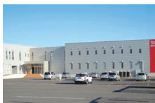
福山（広島）物流倉庫
