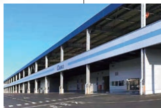
清水（静岡）物流倉庫
